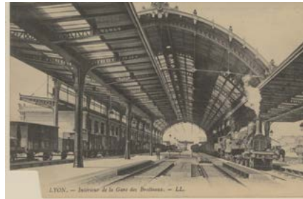
Verrière de la Gare des Brotteaux, ca 1910 © AC Lyon, 4FI 497
