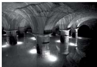
Bassin filtrant de l'usine de Saint-Clair. © « Eau à Lyon » par Louis Froissart © AC Lyon
