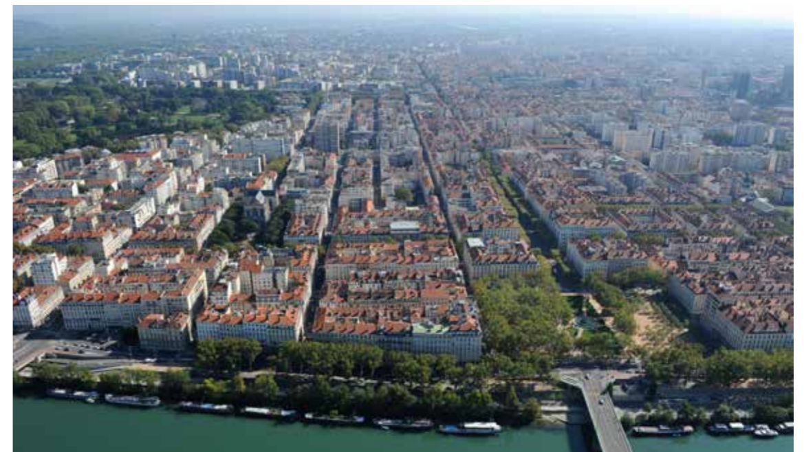
Fig. 46 - Émile Thoubillon, Hôtel de style anglo-normand à l'angle du boulevard des Belges et de l'avenue Verguin, 1905. Fig. 47 - Vue aérienne de l'arrondissement (au premier plan la place Lyautey et le pont Morand) © Ville de Lyon / Muriel Chaulet.
