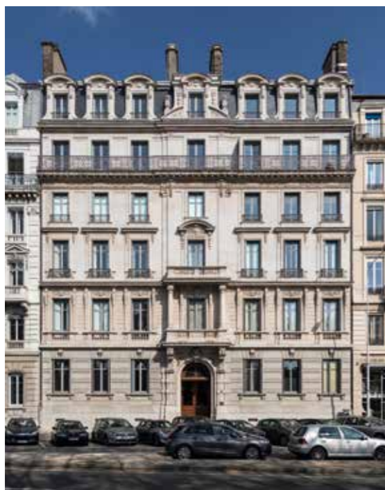
Fig. 48 – François Rostagnat, Immeuble Duc, 1888.
