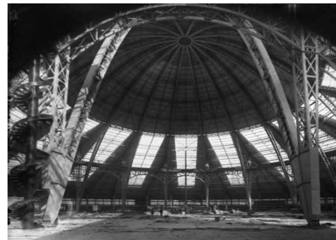
Fig. 28 – Jules Sylvestre, Exposition universelle de Lyon 1894, la grande coupole du palais des expositions (démolie en 1895), 1894, Patiaud et E. Lagarde (ingénieurs-constructeurs), tirage argentin, 18 x 24 cm, Lyon, Bibliothèque municipale (P0546 S 1160).
